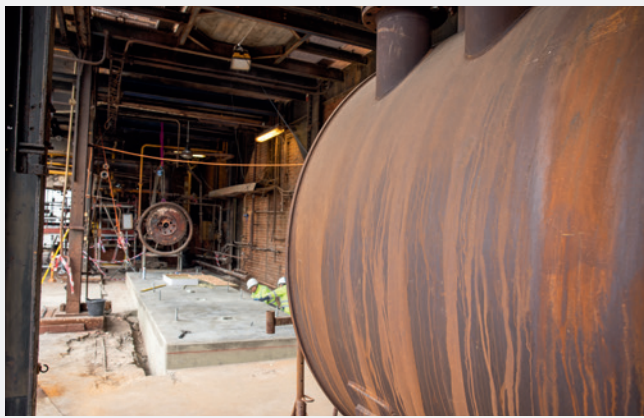
Einbau einer neuen Brennkammer bei Westlake Vinnolit: Umfangreiche, millimetergenaue Bauarbeiten
